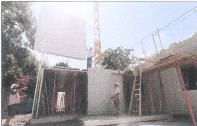
C'est la première fois en France qu'est utilisée la nouvelle solution brevetée par Rector combinant pré-murs et pré-dalles thermiques. Photo Dom Poirier
